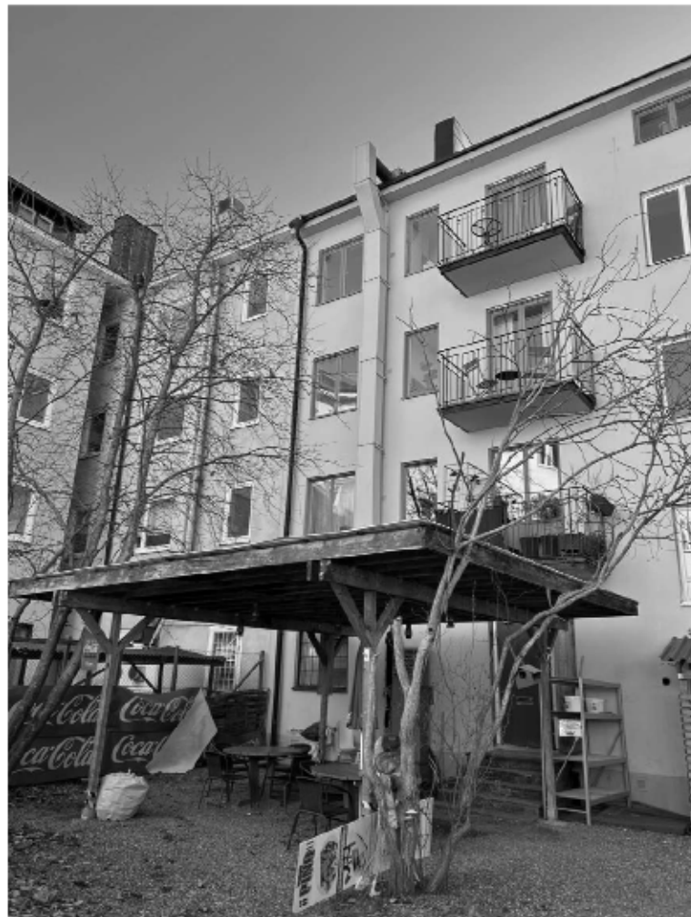
Fasad, fönster, balkonger sett ifrån innergårdån, under renoveringsprocessen.
